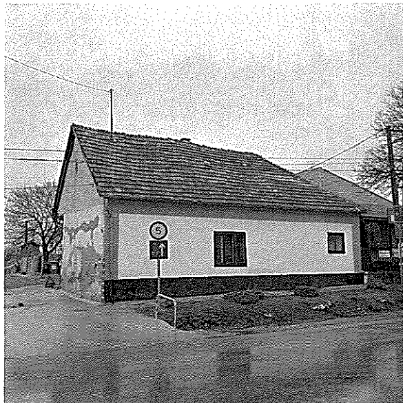
1. fotó: az érintett lakóépület Bajcsy-Zsilinszky utca felőli homlokzata
