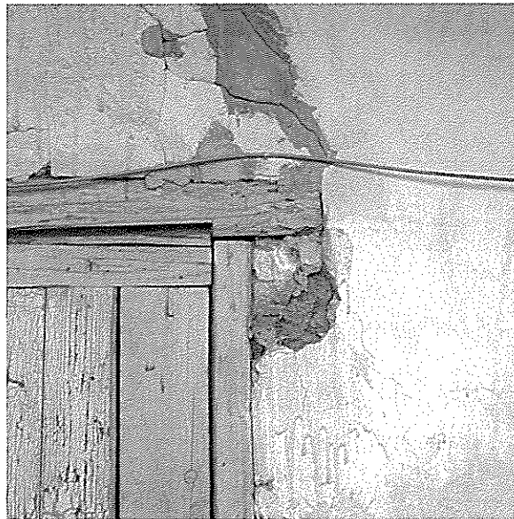
2. fotó: vályog anyagú földszinti teherhordó falazat
