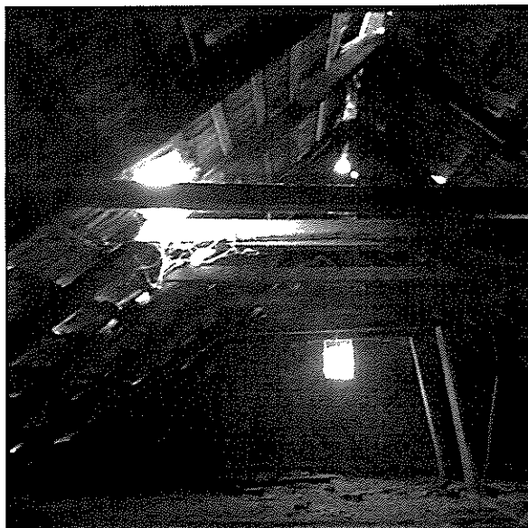
11. fotó: a lakóépület feletti hagyományos ácsszerkezetű, faanyagú fedélszék
