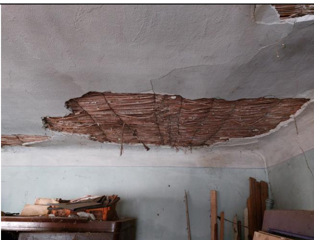
állapotrögzítő belső kép
