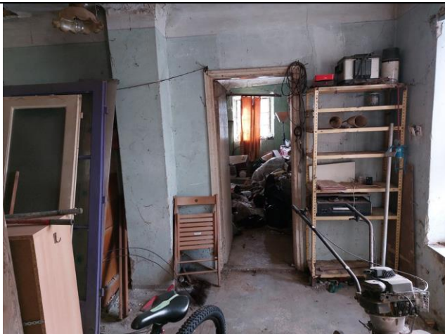
állapotrögzítő belső kép
