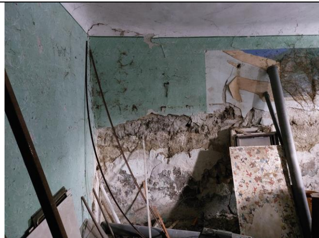
állapotrögzítő belső kép
